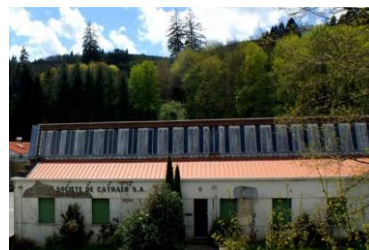
Usine De Cathalo
